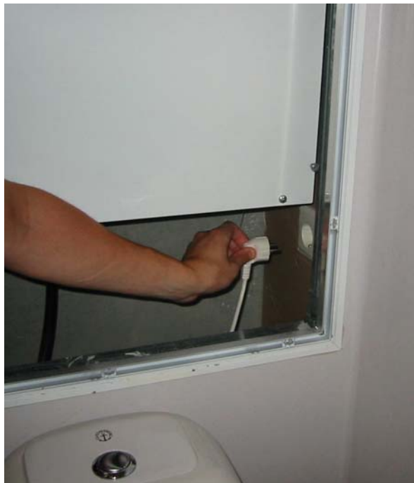
Figur 6: Gjør aggregatet strømløst.
