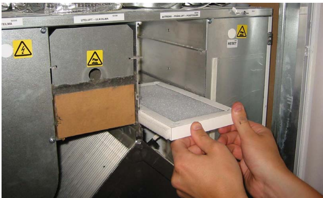
Figur 9: Montering av nytt planfilter for avtrekksluft.
