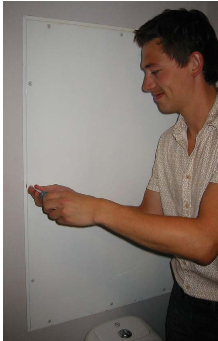
Figur 5: Fjerning av luke foran kabinettet.
