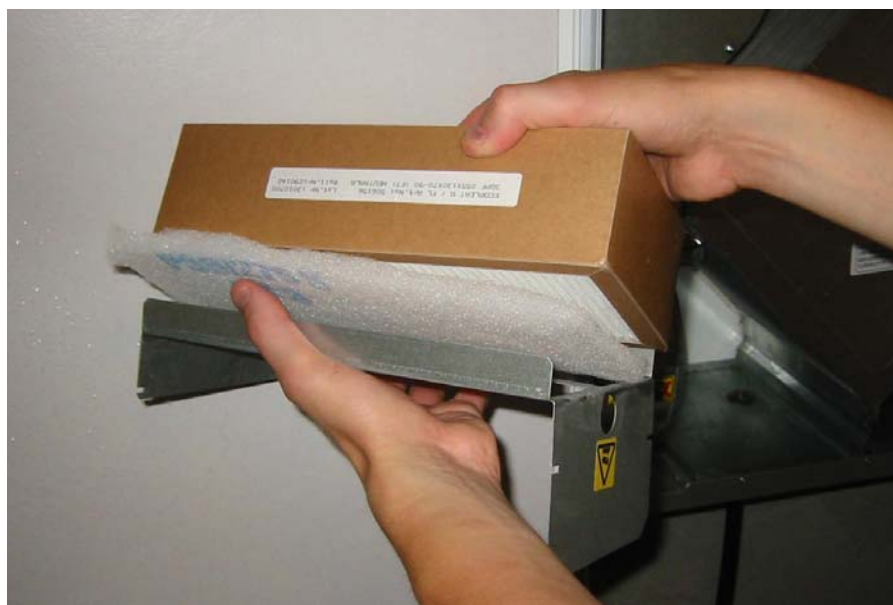
Figur 13: Sammensetting av de nye filtrene og stativet.
