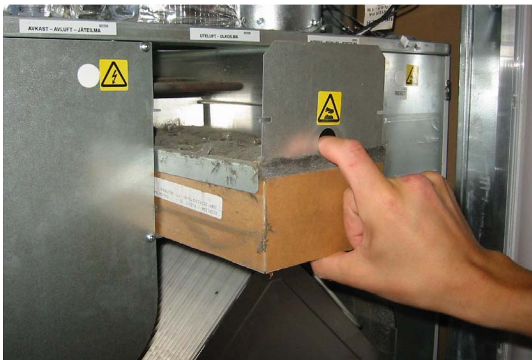
Figur 10: Ta ut filterene for uteluften og stativet over de.
