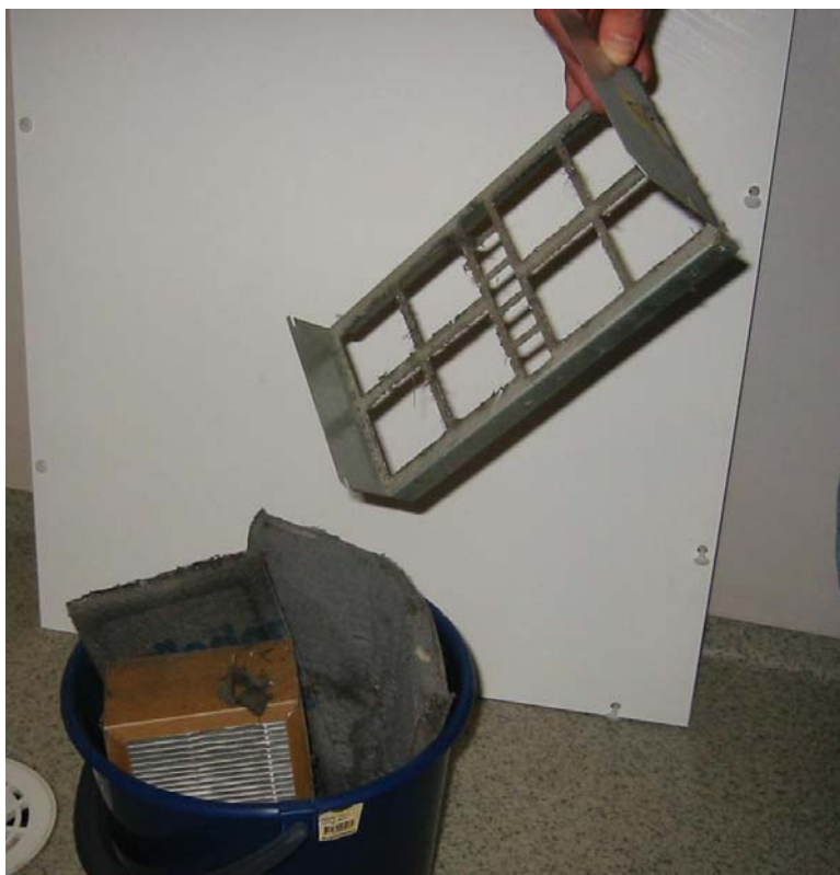
Figur 12: Kast de brukte uteluftfiltrene.
