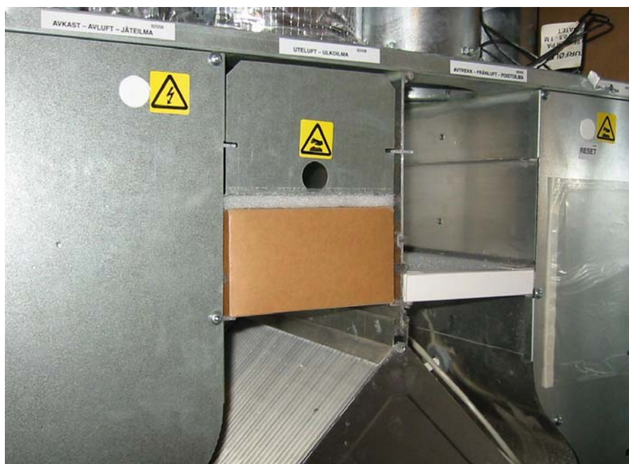
Figur 15: Montering av 3 nye filtre ferdig.
