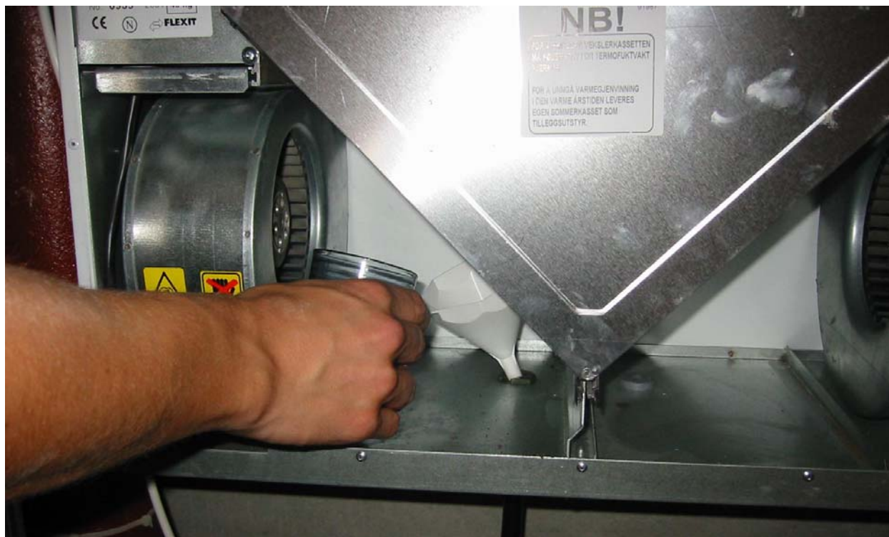
Figur 4: Etterfylling av vann i vannlås.
