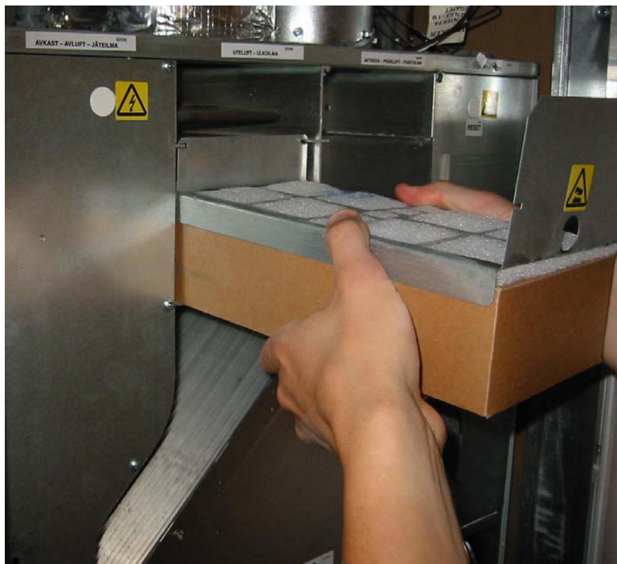
Figur 14: Innsetting av nye uteluftfiltre.
